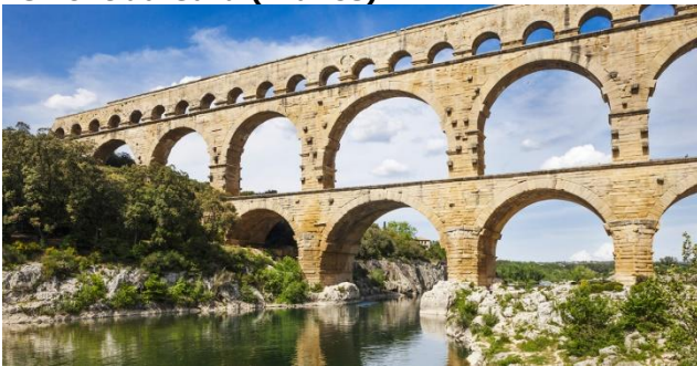
Le Pont du Gard (France)
